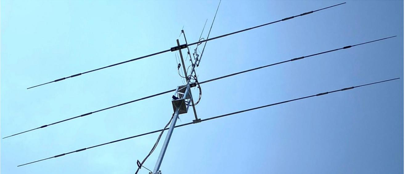
**Pour des performances optimales, il est recommandé de l'installer à une hauteur d'au moins 5-6 m au-dessus du sol.**
